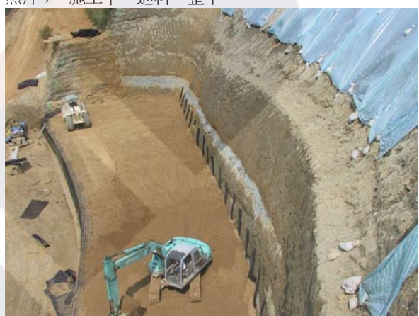
照片 8、施工中—夯實
