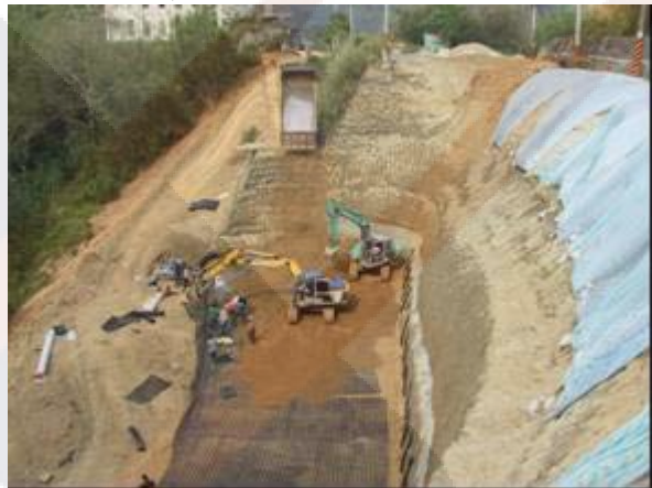
照片 7、施工中—進料、整平
