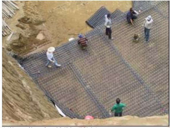
照片 6、施工中—鋪設加勁格網
