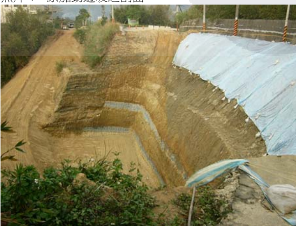
照片 5、基礎開挖完成
