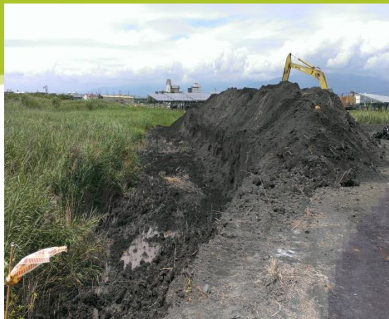
加勁基礎開挖整地
