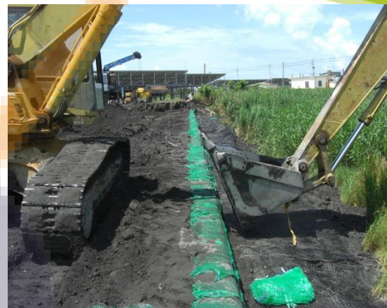
加勁牆面修整
