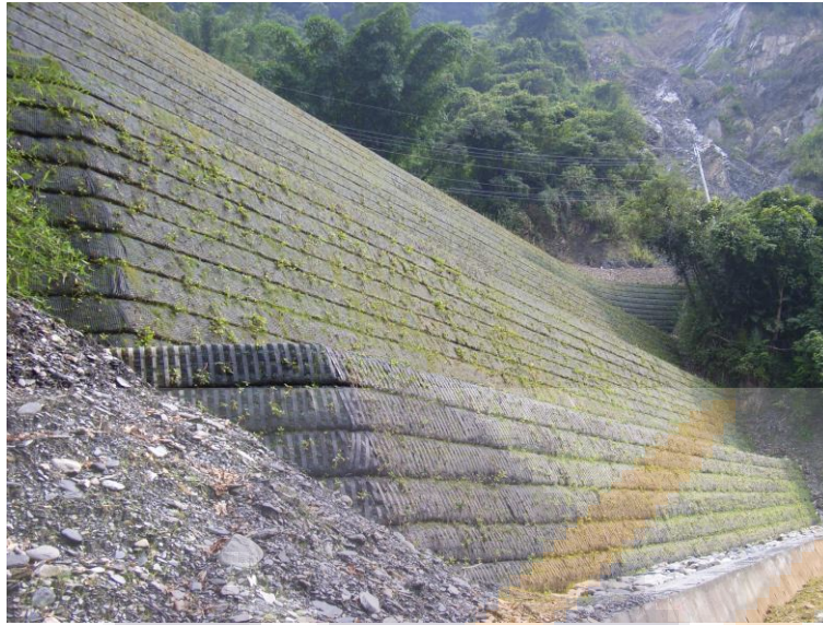
照片 2 高度超過 20m 之加勁結構
