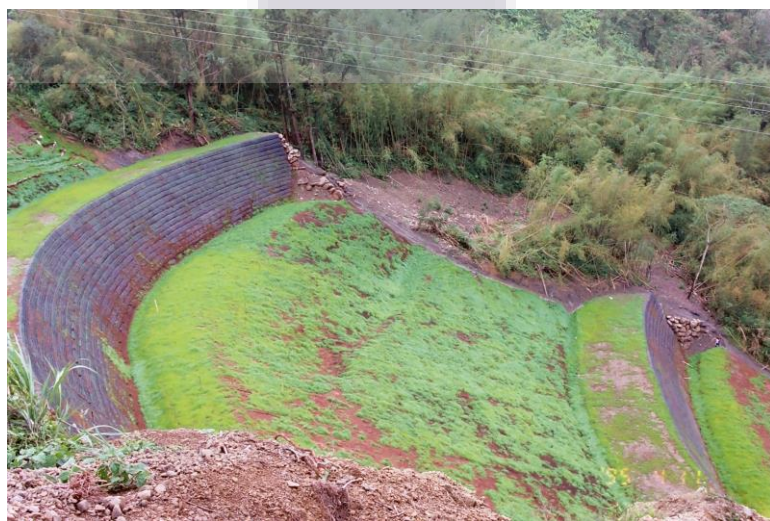
照片 7 應用於崩塌地整治之加勁結構
