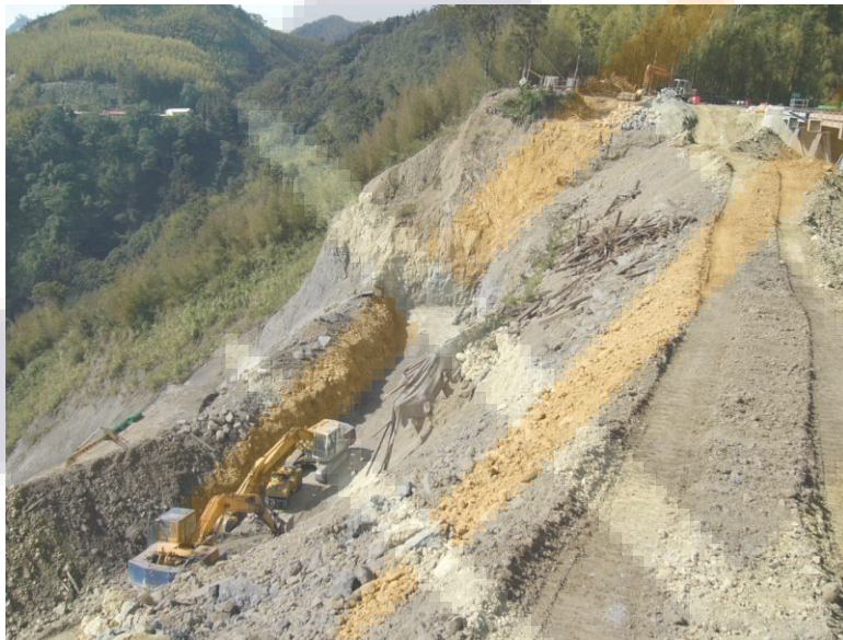
照片 6 崩塌地應用加勁工法所需之平台開挖
