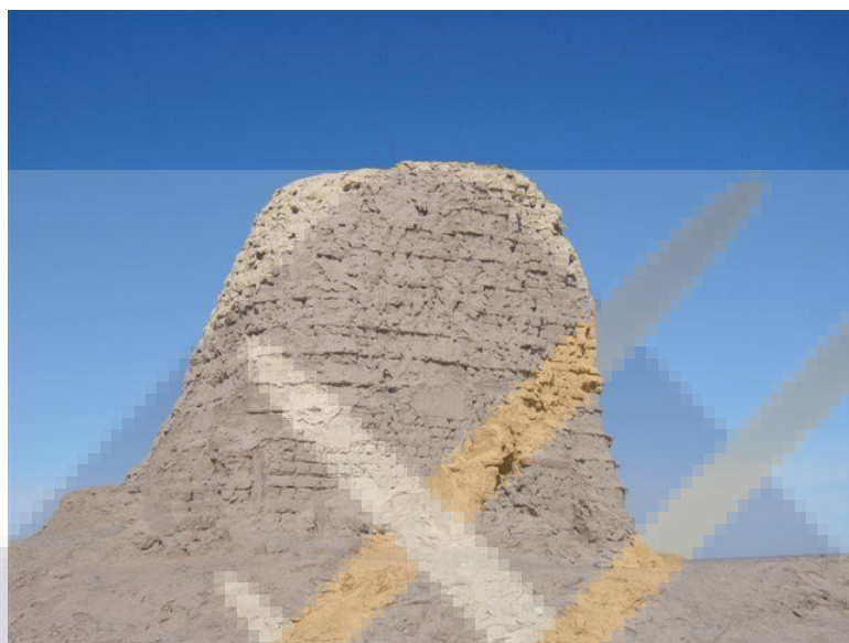
照片 1 歷經 2000 多年之加勁結構
