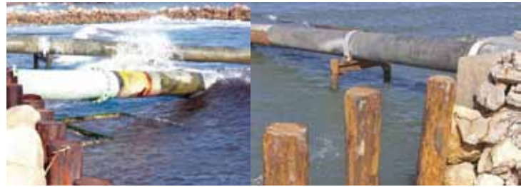
▲ 海岸保護施工前
